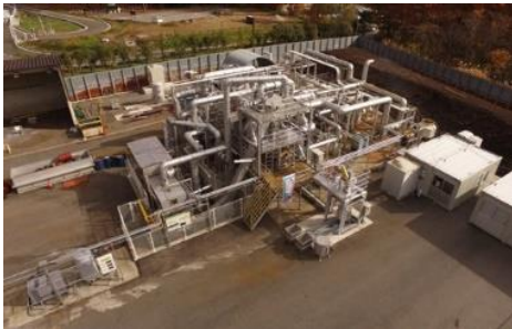
鉄建建設・バイオマスガス発電
