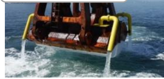
東洋建設・ サイホン式余水排水工法
