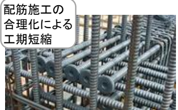
清水建設・Tヘッド工法鉄筋
